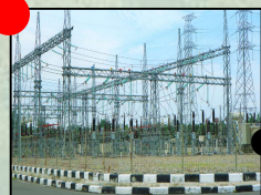
电力 150 千伏 / 60 兆伏安
