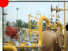
输气管道 75 MMSCFD
