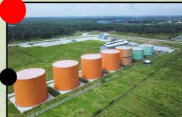
油罐区 2 x 3000 吨 棕榈仁油 5 x 5000 吨 棕榈油
